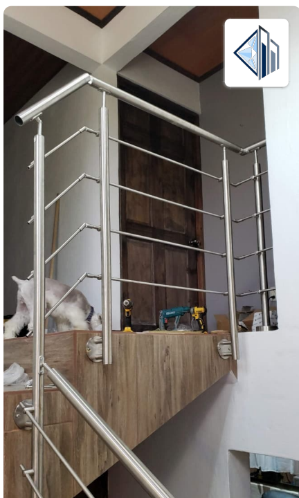
Instalación de baranda en balcón
