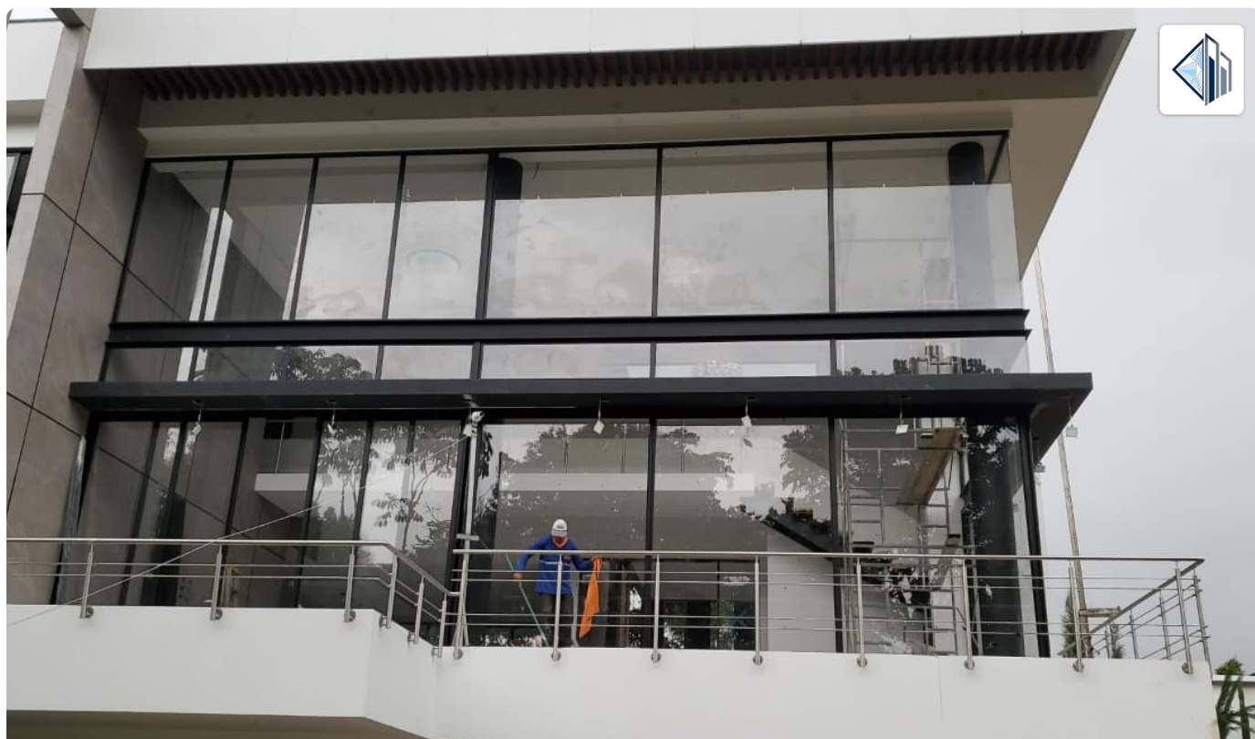
Fachada de vidrio de dos niveles — estructura de aluminio
