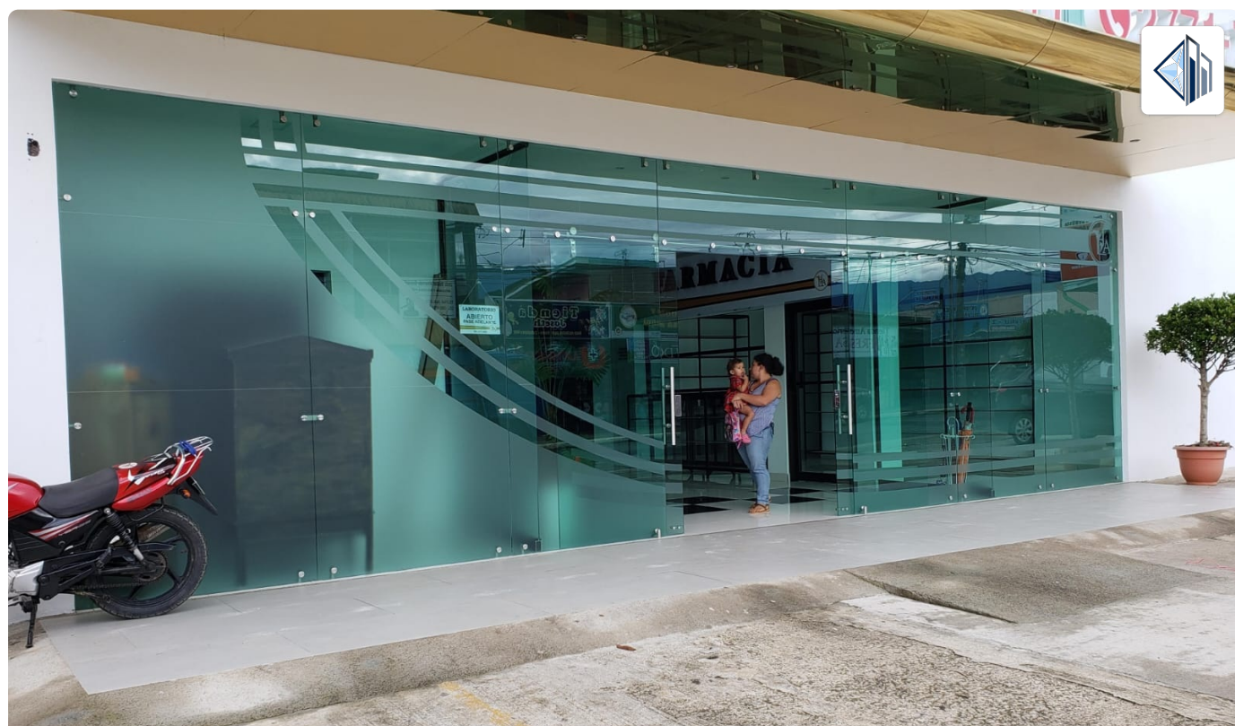
Fachada de vidrio templado — acceso principal de farmacia
