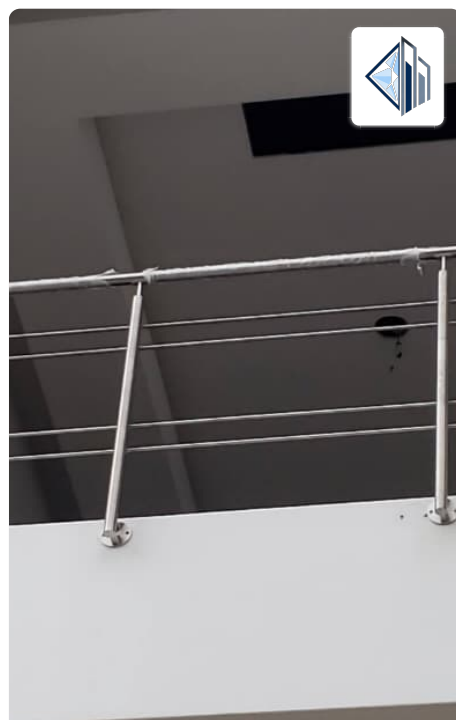
Baranda con cables sobre vacío interior
