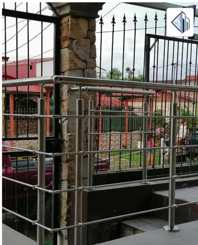
Baranda perimetral sobre vacío de escalera
