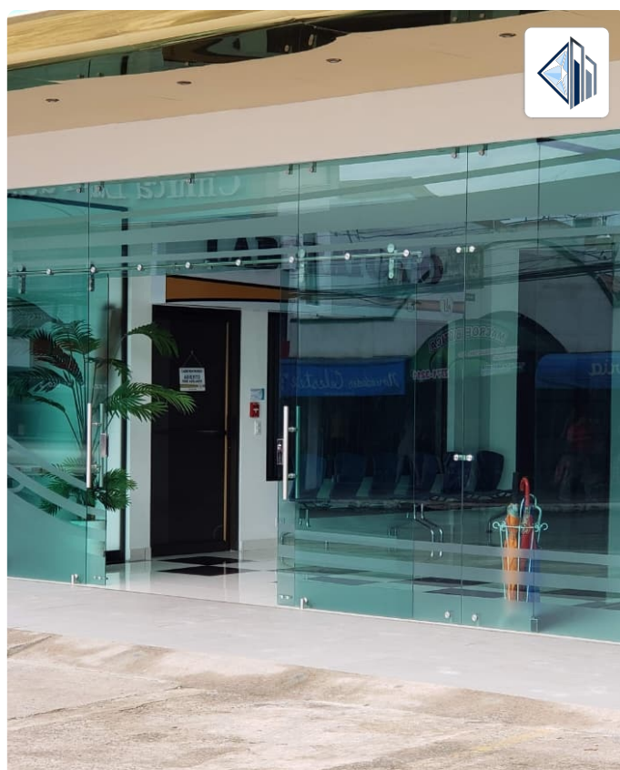
Detalle de puertas y paños de vidrio templado
