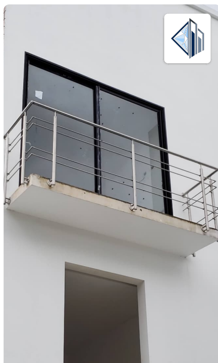
Baranda de acero en balcón volado
