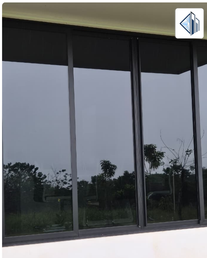
Sistema corredizo en aluminio color oscuro
